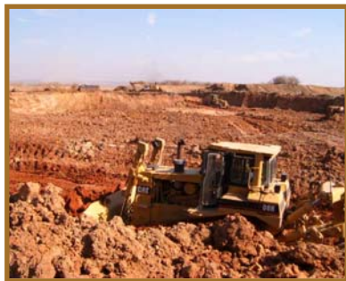
Luilu tailings construction
